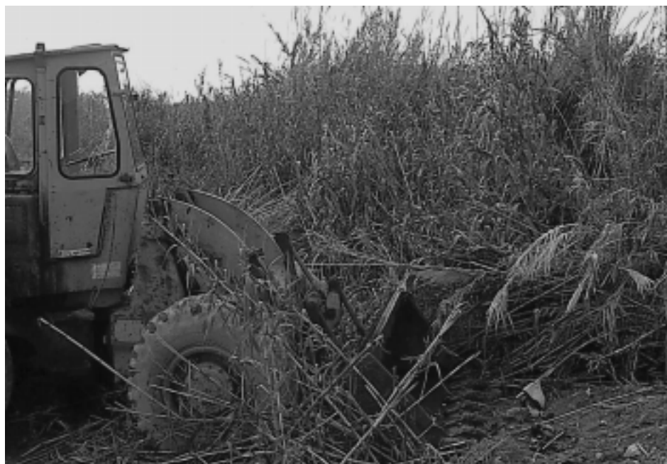
Figura 17. Uno de los principales motivos de desaparición de los humedales en el Sudeste Ibérico ha sido su destrucción para usos agrícolas o urbanísticos. En la foto, roturación de vegetación palustre en el delta del río Adra (Almería). Fotografía: Mariano Paracuellos.
